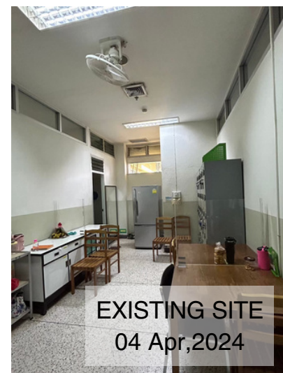
EXISTING SITE 04 Apr,2024
