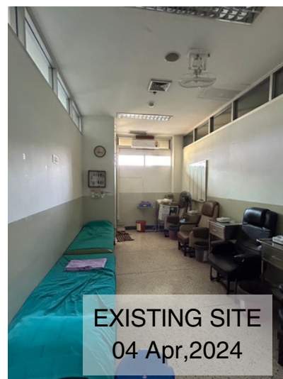
EXISTING SITE 04 Apr,2024
